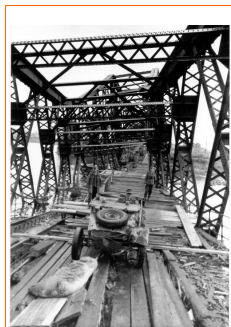
Le viaduc d'Eauplet à Rouen
