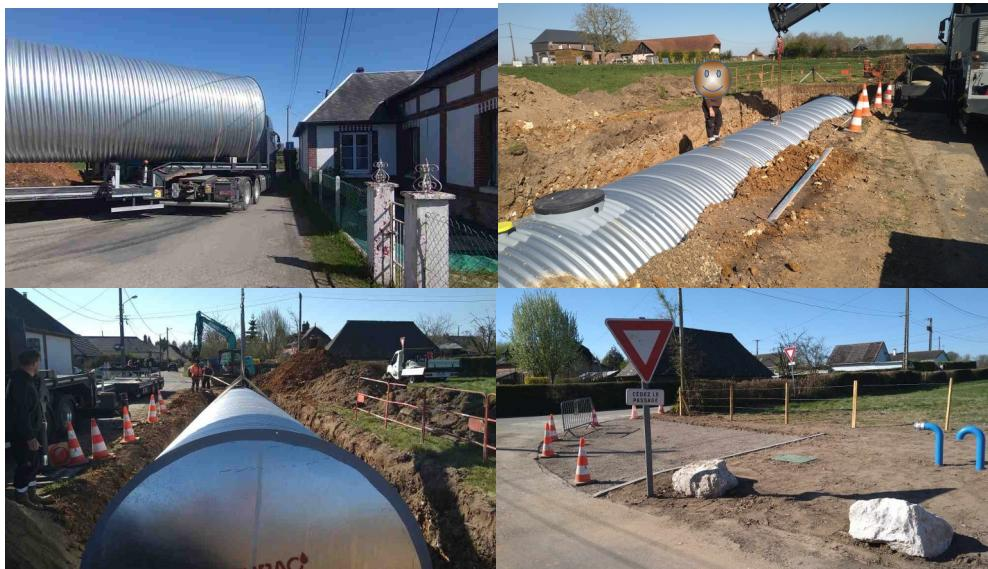
Une réserve incendie enterrée de 120m<sup>3</sup> vient d'être installée au Thil conformément au règlement départemental de défense extérieure contre l'incendie. Elle permettra la protection d'une partie du Thil ainsi que l'autorisation de nouvelles constructions.
