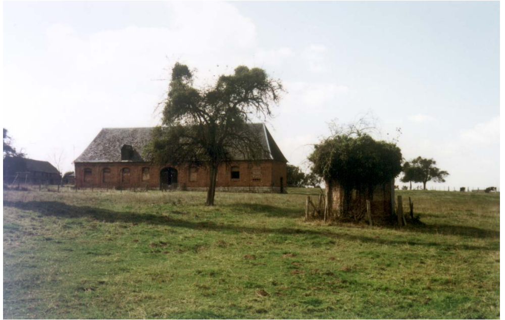
une grange à réhabiliter près de la place de l'église
